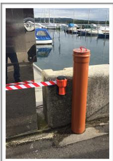
1. Le poteau central du dispositif de sécurité se trouve à l'intérieur du cylindre orange disposé derrière l'installation de récupération des eaux noires.
